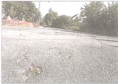
Ekebergveien asfalteres fra Sæterkrysset til Ljabruveien.
